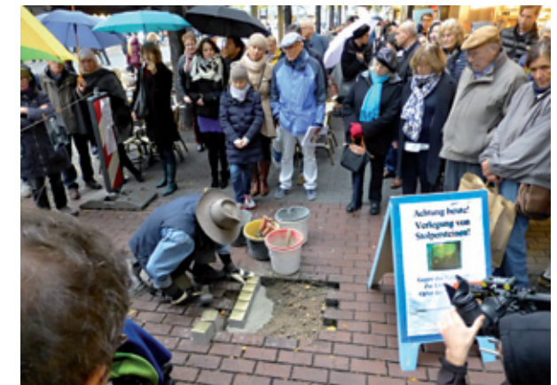
Verlegung der Steine in den Planken für die Familie Droller 2016
