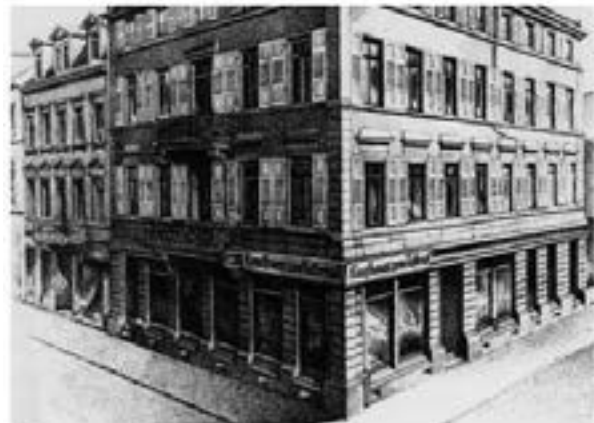
Die Vetterecke Schwetzingen-/Thoräckerstraße, Foto: 20er Jahre, Quelle: „Auf den Spuren Heinrich Veters“
